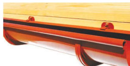
В держателях металлических и ПВХ монтаж начинаем с вложения закругленного наружу выступа желоба в передний выступ держателя, а дальше защелкиваем внутренний край желоба под задний выступ.
