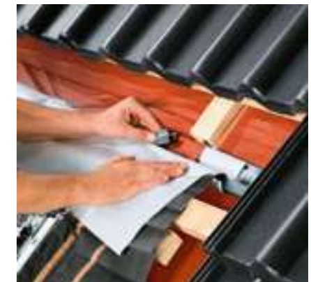
Установка дренажного жолоба
