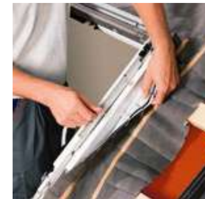
Швидке і щільне з'єднання BFX з коробкою вікна, завдяки новому бутиловою клеючому шару
